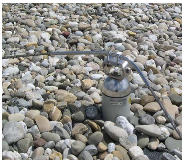
Fig. 54 Eksempel på festepunkt for sikkerhetsline
