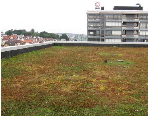
Sedumtak på Comfort Hotel Square i Stavanger. (Foto: SINTEF Community)
