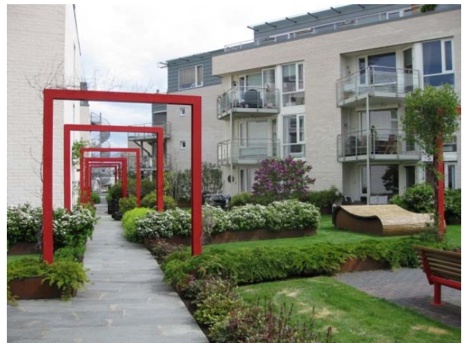
Takhage på Thaulowkaia i Trondheim som intensiv grønt tak med beplantninger og oppholdsarealer. (Foto: SINTEF Community)
