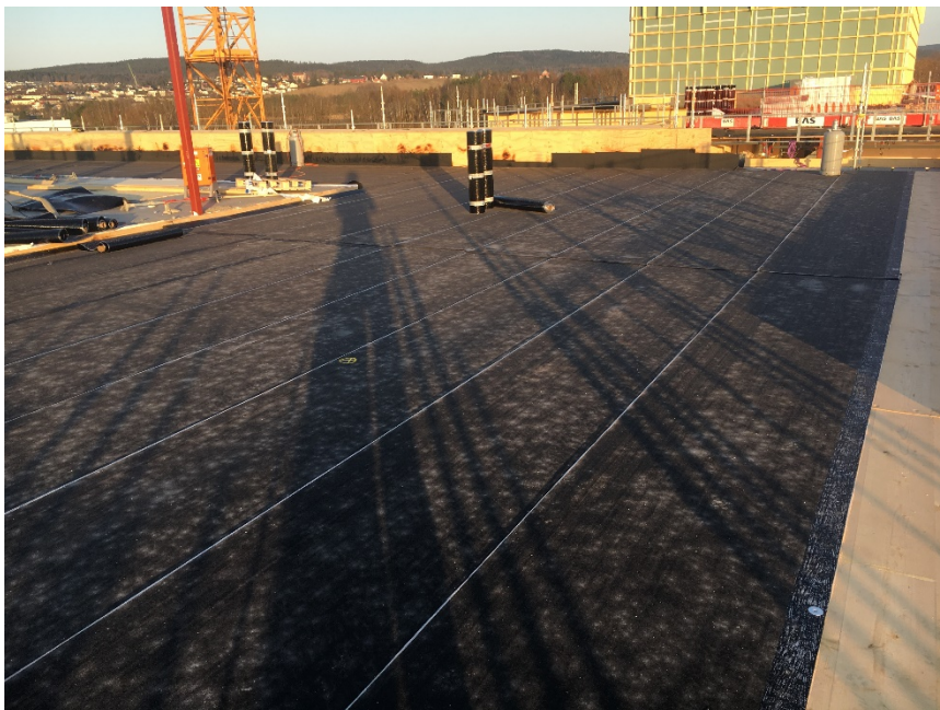
Figur 2: Eksempel på tidlig provisorisk tekking av tørre massivtreelementer, som sikrer lav byggfukt (Foto: Vidar Jacklin, BMI Group)
