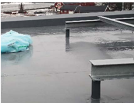
Figur 5: Eksempel på bruk av innfestingsfot (Foto: Protan)
