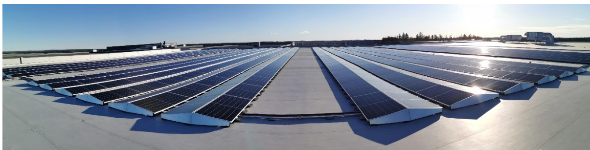
Figur 2: Eksempel på solpaneler med lav helningsvinkel og med orientering mot øst og vest (Foto: FUSen)
