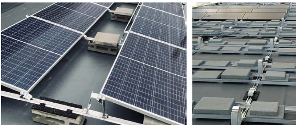
Figur 13: Eksempler på ballastert løsning (Foto: Protan)
