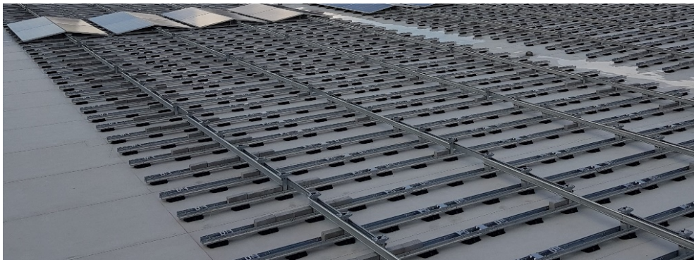
Figur 12: Eksempel på ballastert løsning (Foto: FUSen)
