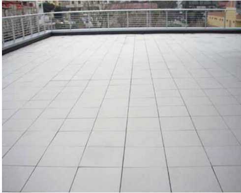
Figur 8.2: Terrasse med flis med åpne fuger lagt på klosser.
