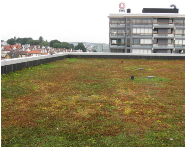
Sedumtak på Comfort Hotel Square i Stavanger. (Foto: SINTEF Byggforsk)
