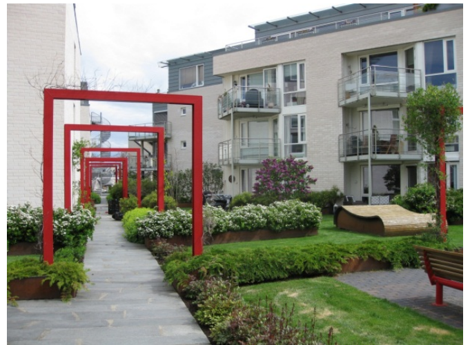
Takhage på Thaulowkaia i Trondheim som intensiv grønt tak med beplantninger og oppholdsarealer. (Foto: SINTEF Byggforsk)
